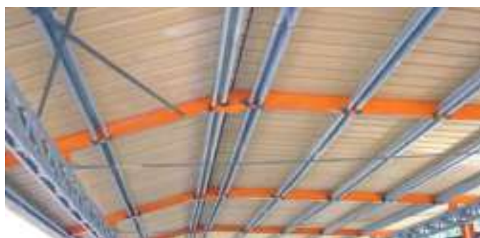
Nelle immagini sopra alcuni esempi di strutture portanti ed arcarecci per le lastre COVER-LIFE
