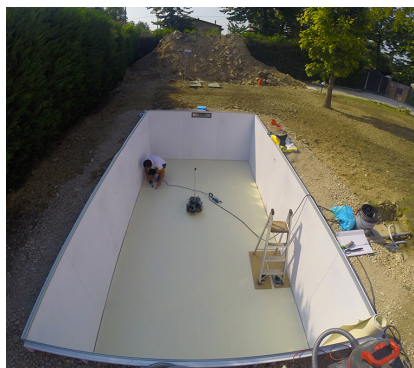
5. Impiantistica e applicazione del rivestimento del colore scelto
