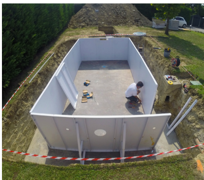
4. Montaggio dei pannelli eseguito da personale qualificato
