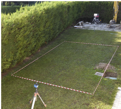
1. Tracciatura del terreno secondo le dimensioni scelte
